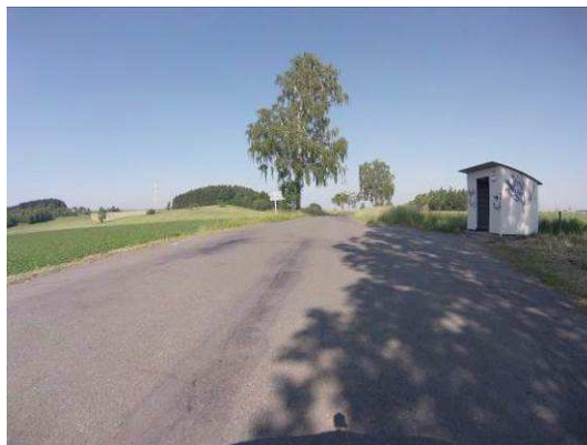
Hl. koroze, vysprávký, podélná trhlina
