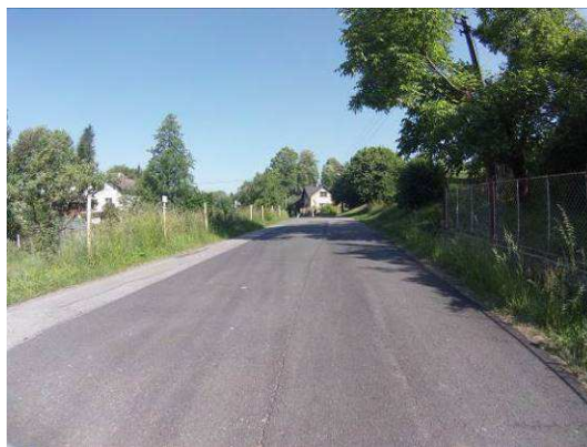
Podélná trhlina
