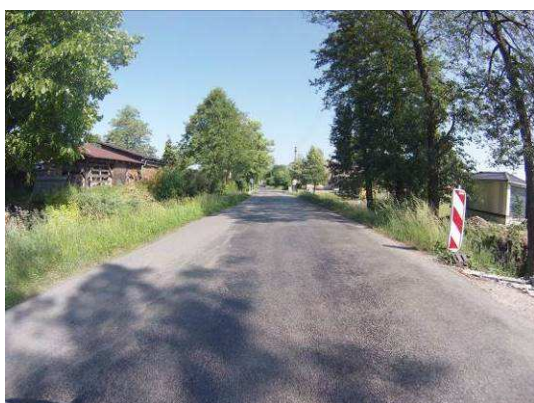
Ztráta makrotextury, vysprávkvy, podélné a moz. trhliny
