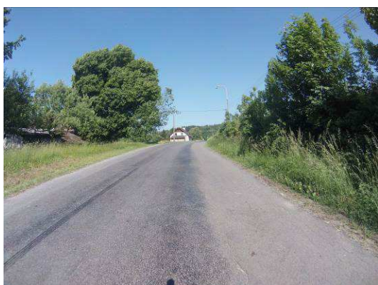
Ztráta makrotextury, vysprávky, mozaikové trhliny
