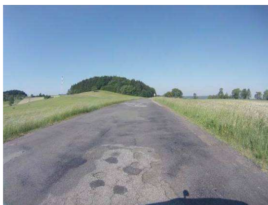
Hl. koroze, začínající výtlučky, vysprávký, moz. trhliny
