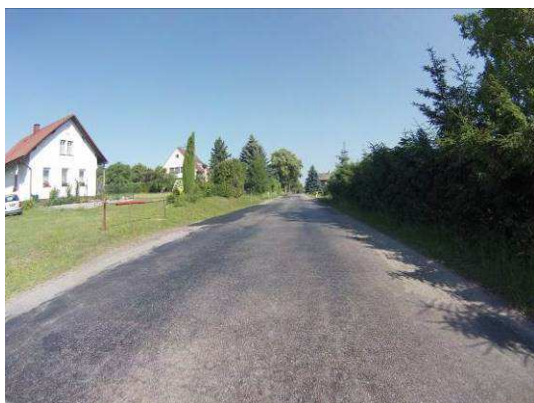
Ztráta makrotextury, vysprávkvy, mozaikové trhliny
