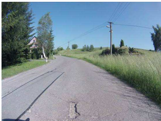
Hl. koroze, výtluky, vysprávkky, mozaikové trhliny
