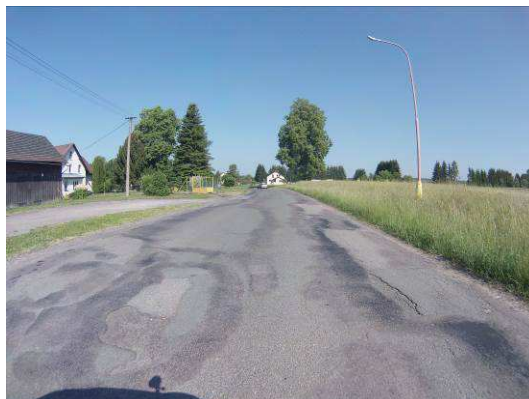
Ztráta makrotextury, hl. koroze, výtluky, vysprávk
