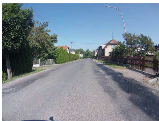
Hl. koroze, vysprávk, mozaikové trhliny
