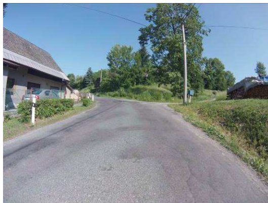
Ztráta makrotextury, hl. koroze, vysprávký, trhliny
