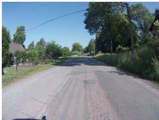
Hl. koroze, vysprávkky, podélné a mozaikové trhliny
