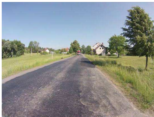
Ztráta makrotextury, mozaikové trhliny
