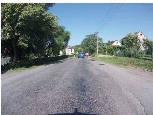
Ztráta makrotextury, vysprávky, mozaikové trhliny
