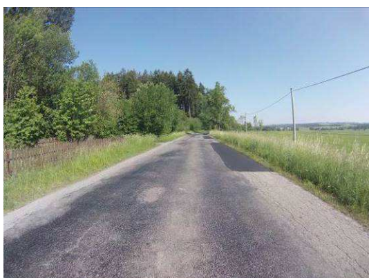
Ztráta makrotextury, vysprávký, mozaikové trhliny
