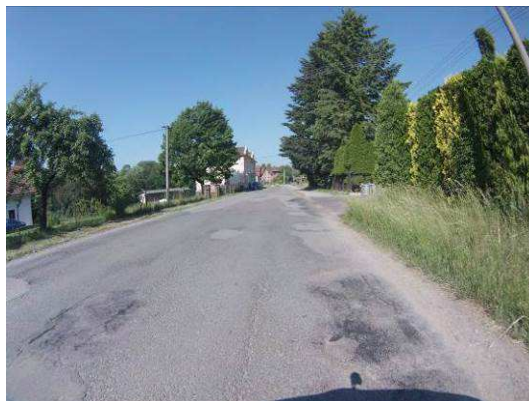
Ztráta makrotextury, hl. koroze, vysprávkky, trhliny
