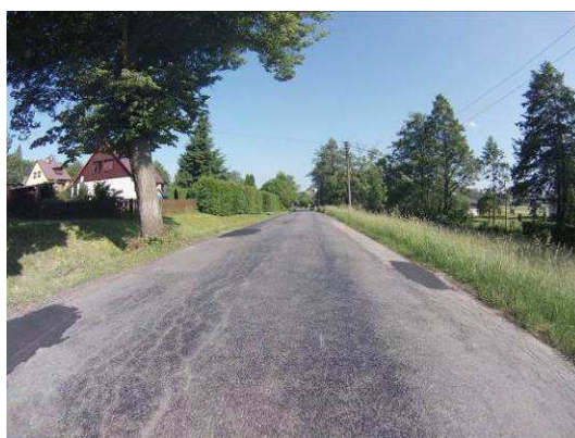
Ztráta makrotextury, vysprávkvy, mozaikové trhliny
