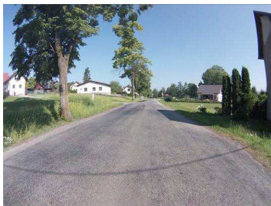
Ztráta makrotextury, mozaikové trhliny
