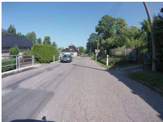
Hl. koroze, vysprávkky, mozaikové trhliny
