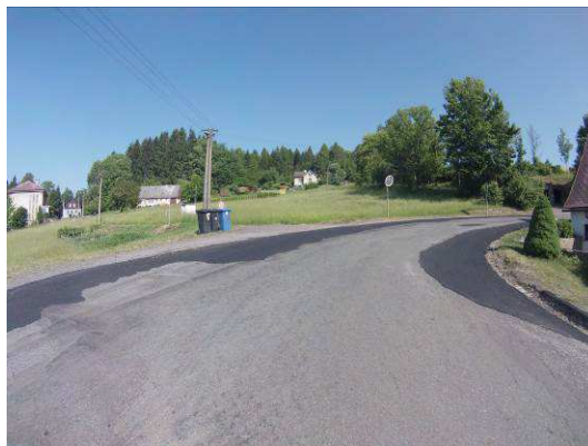
Hl. koroze, vysprávkvy, mozaikové trhliny
