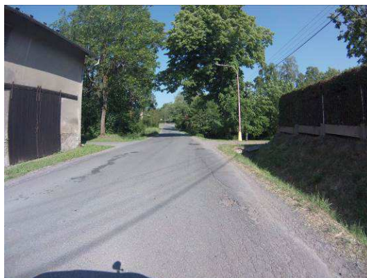
Hl. koroze, výtluky, mozaikové trhliny
