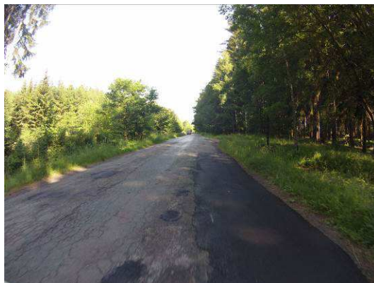
Hl. koroze, výtluky, vysprávký, moz. až síťové trhliny
