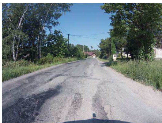
Ztráta makrotextury, hl. koroze, vysprávk
