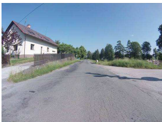
HL. koroze, vysprávkvy, mozaikové trhliny
