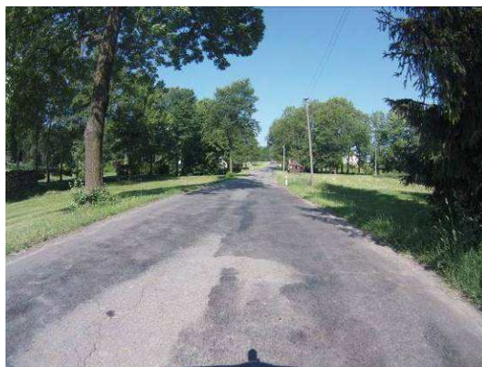
Ztráta makrotextury, vysprávkky, mozaikové trhliny
