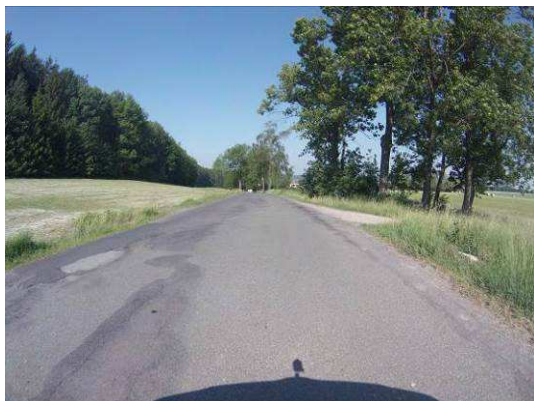
Hl. koroz, vysprávk, podélné trhliny
