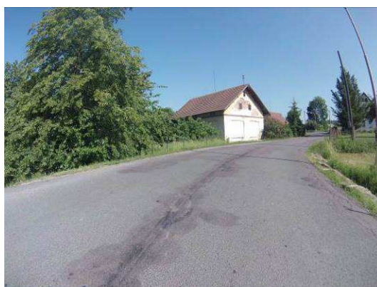
Hl. koroze, vysprávký, podélné a mozaikové trhliny
