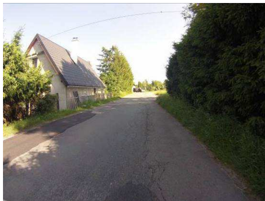
Ztráta makrotextury, vysprávký, podélné a moz. trhliny
