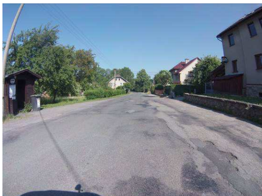
Hl. koroze, výtluky, vysprávk, mozaikové trhliny
