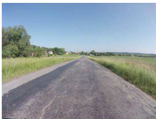
Ztráta makrotextury, vysprávký, mozaikové trhliny
