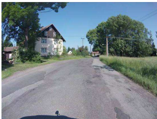
Hl. koroze, výtluky, vysprávký, podélné a moz. trhliny
