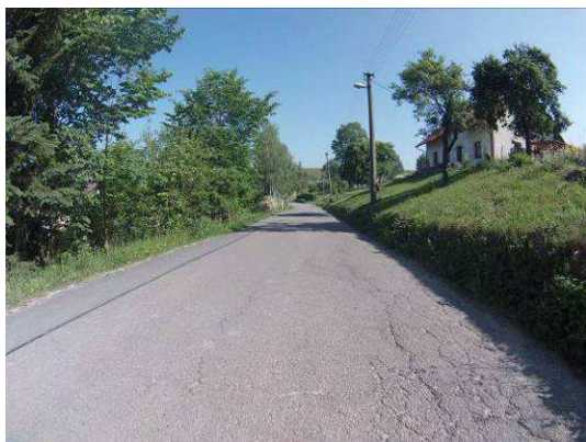
Hl. koroze, vysprávkky, mozaikové trhliny
