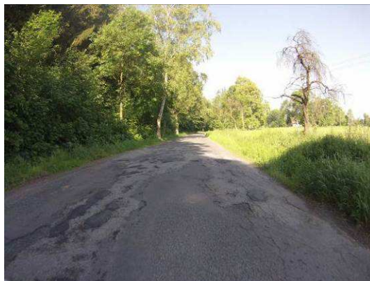
Hl. koroze, výtluky, vysprávký, mozaikové trhliny
