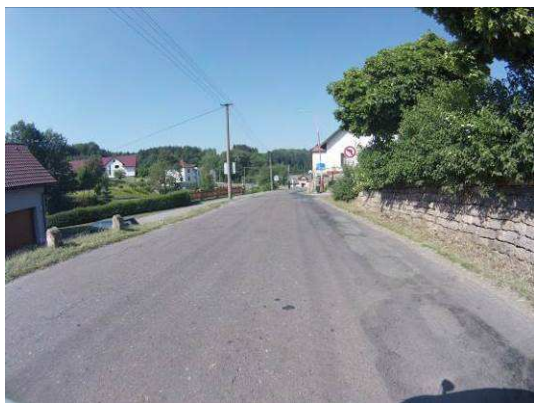
Hl. koroze, vysprávkky, mozaikové trhliny
