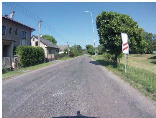
Hl. koroze, vysprávky, mozaikové trhliny
