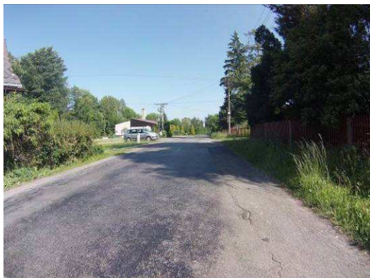
Ztráta makrotextury, vysprávký, mozaikové trhliny
