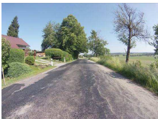
Ztráta makrotextury, vysprávký, mozaikové trhliny
