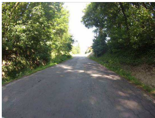
Ztráta makrotextury, vysprávký, moz. až síťové trhliny
