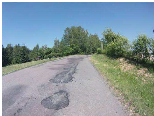
Ztráta makrotextury, hl. koroze, vysprávkky
