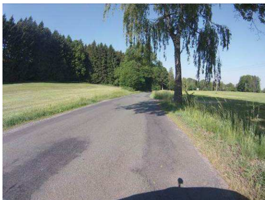
Hl. koroz, vysprávk, podélné trhliny
