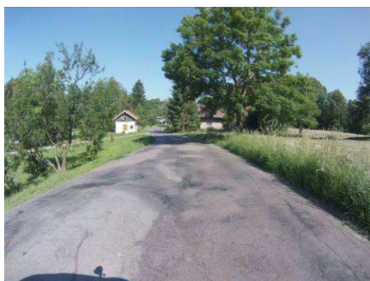
Ztráta makrotextury, vysprávký, podélné a moz. trhliny
