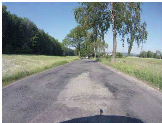
Ztráta makrotextury, vysprávk, začínající výtlučky
