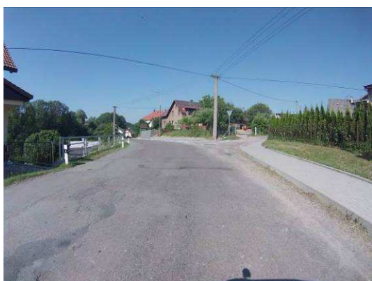
Hl. koroze, vysprávkky, podélné a mozaikové trhliny
