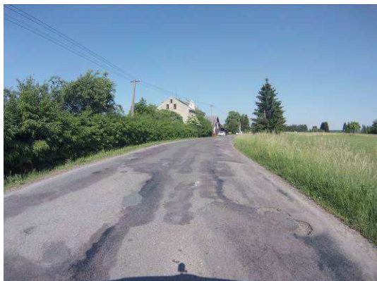
Ztráta makrotextury, hl. koroze, výtluky, vysprávk
