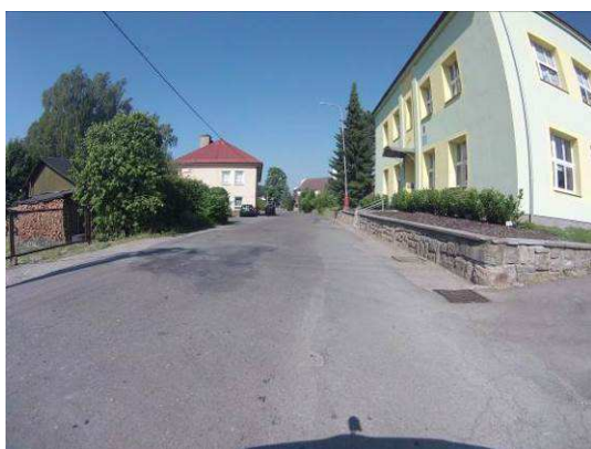
Hl. koroze, vysprávkky, mozaikové trhliny
